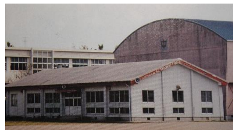
当時の卒業アルバムより 武道館横の旧体育館
